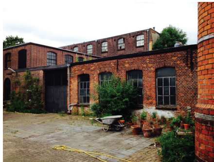
Voormalige leerfabriek, Rijssen.
