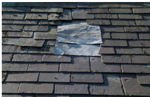
Aangevuld met dezelfde soort leien in hetzelfde dekkingspatroon: vergunningvrij
