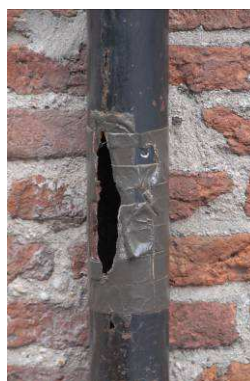
Links: kapotte delen van de hemelwaterafvoer met hetzelfde materiaal vervangen: vergunningvrij
