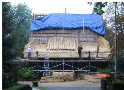
Vervangen rietdekking. Vergunning nodig.
